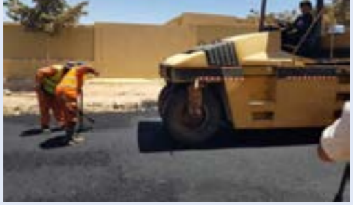
● عمال يستأنفون رصف أحد الطرق في كابو
