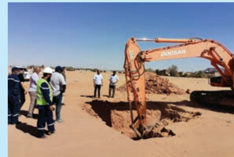
● أعمال حفر قواعد أبراج خط كهرباء أوباري - الفجيج. (الشركة العامة للكهرباء)
